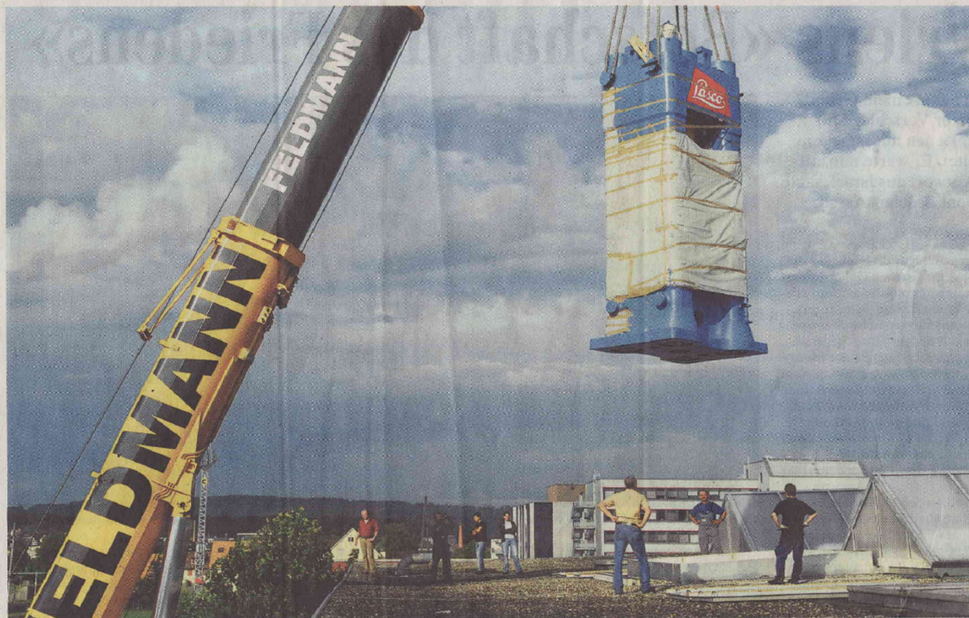
Sulzer-Areal Oberwinterthur: Ein Pneukran hebt die acht Meter hohe und fast 100 Tonnen schwere Presse auf ihren Platz in der Fabrik. Bild: Marc Dahinden
